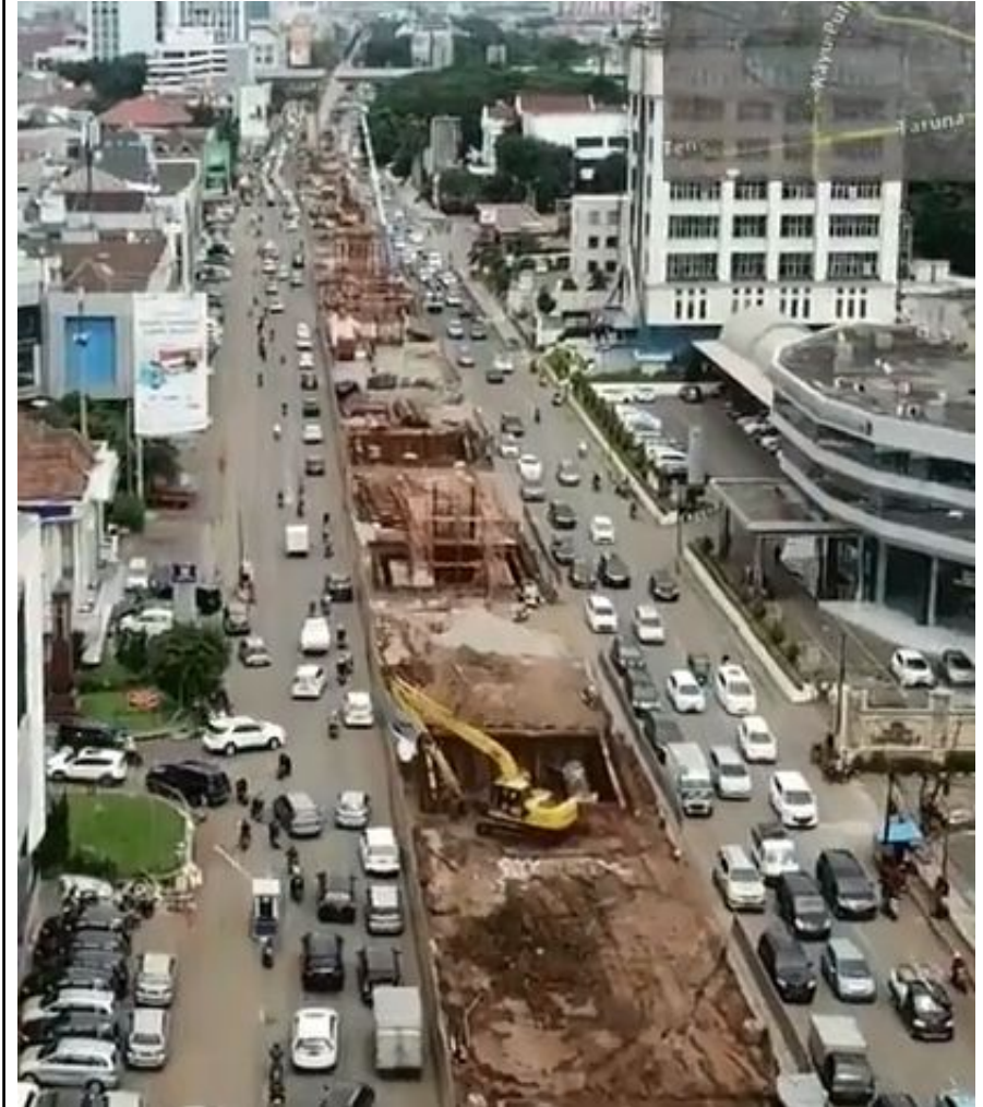
PROYEK TOL TENGAH KOTA JAKARTA
