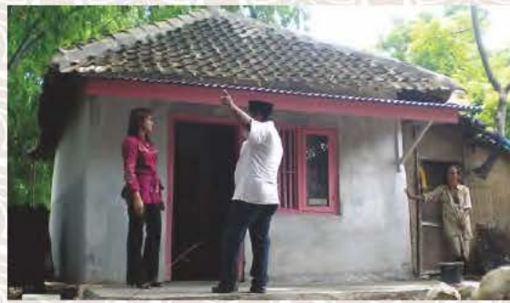
Perbaikan Rumah Tidak Layak Huni (RTLH) di Madiun Renovation Rumah Tidak Layak Huni (RTLH) in Madiun
