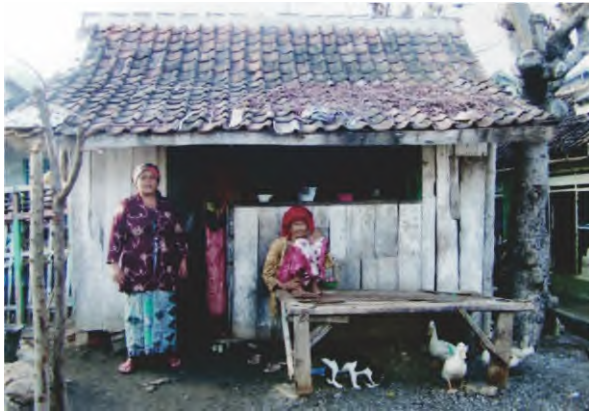
Sebelum perbaikan Before renovation
