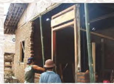
Perbaikan Rumah Tidak Layak Huni (RTLH) di Surabaya Renovation Rumah Tidak Layak Huni (RTLH) in Surabaya
