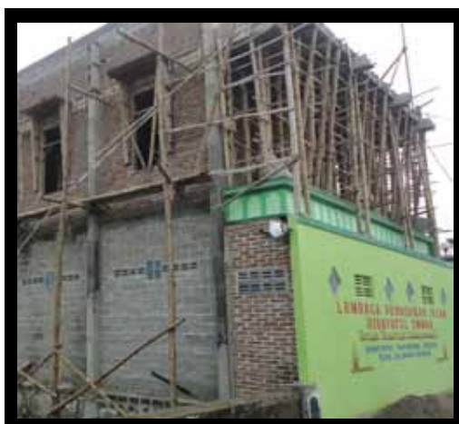
Bantuan CSR untuk perbaikan gedung SD Islam Hidayatul di Kabupaten Magetan
